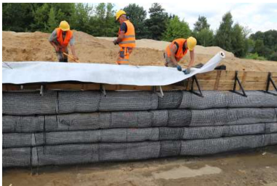
Fot.2 Materace wykonane z gruntu zbrojonego w systemie biernym
