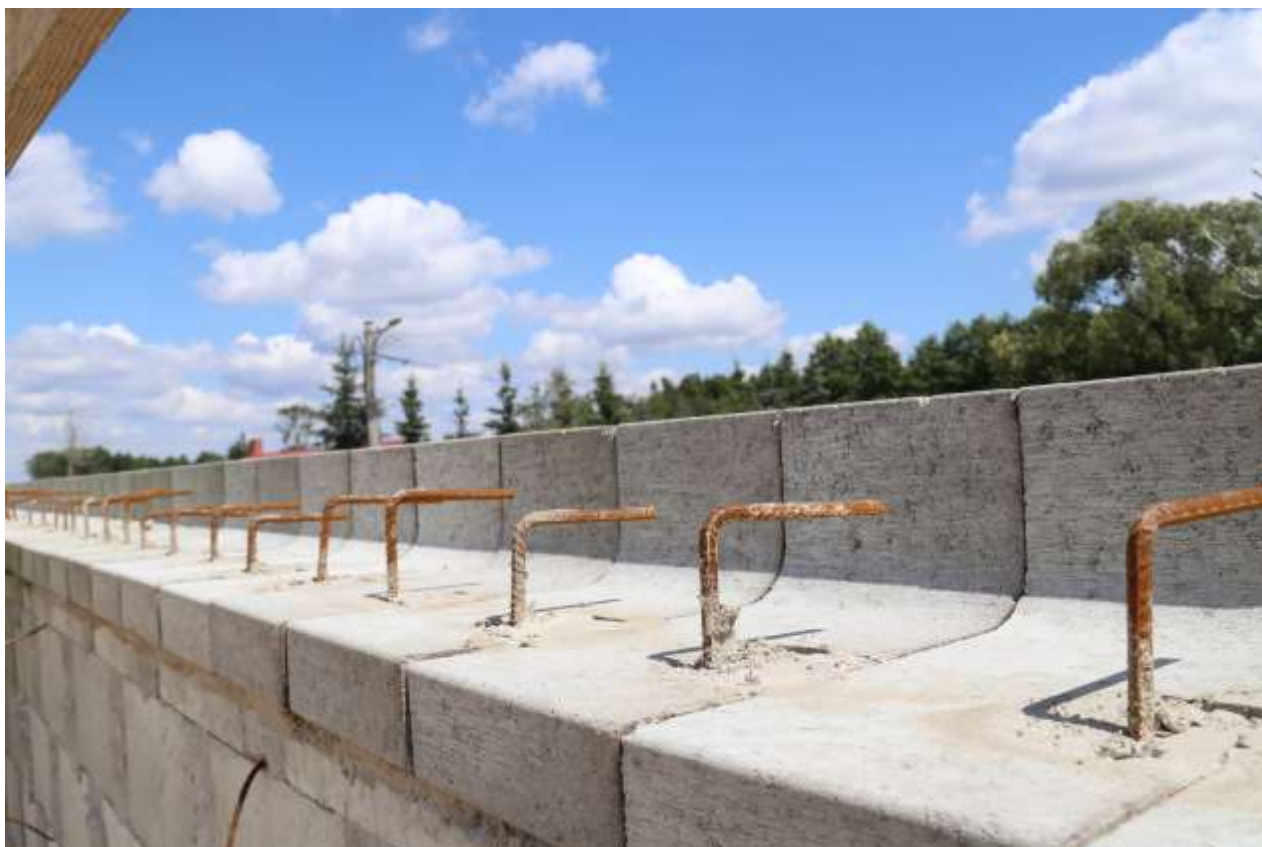
Fot.3 Zastosowanie kapy w kształcie litery T pozwoliło na uzyskanie znacznych oszczędności
