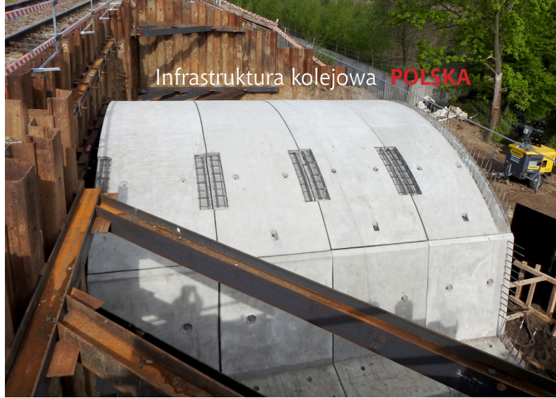
Ryc. 4. Konstrukcja nośna obiektu w km 267,333 w miejscowości Nekla
