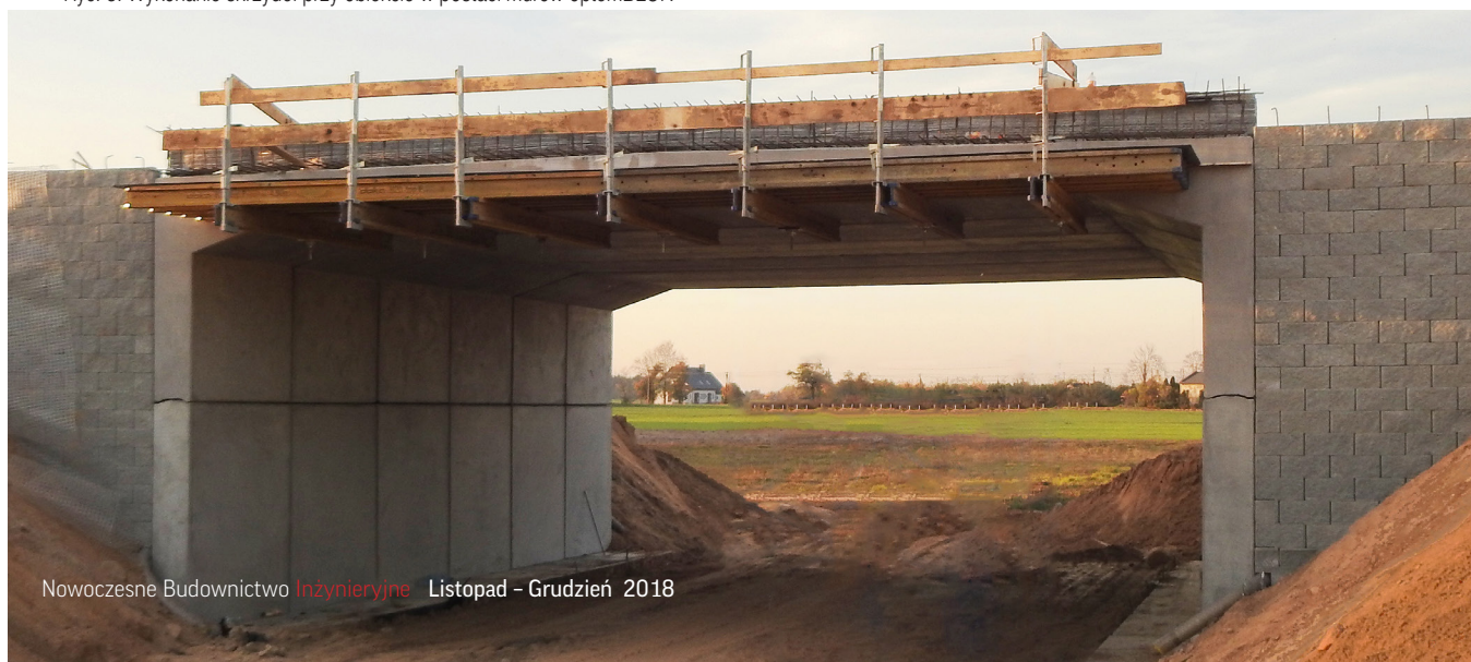
Ryc. 3. Wykonanie skrzydeł przy obiekcie w postaci murów optemBLOK
