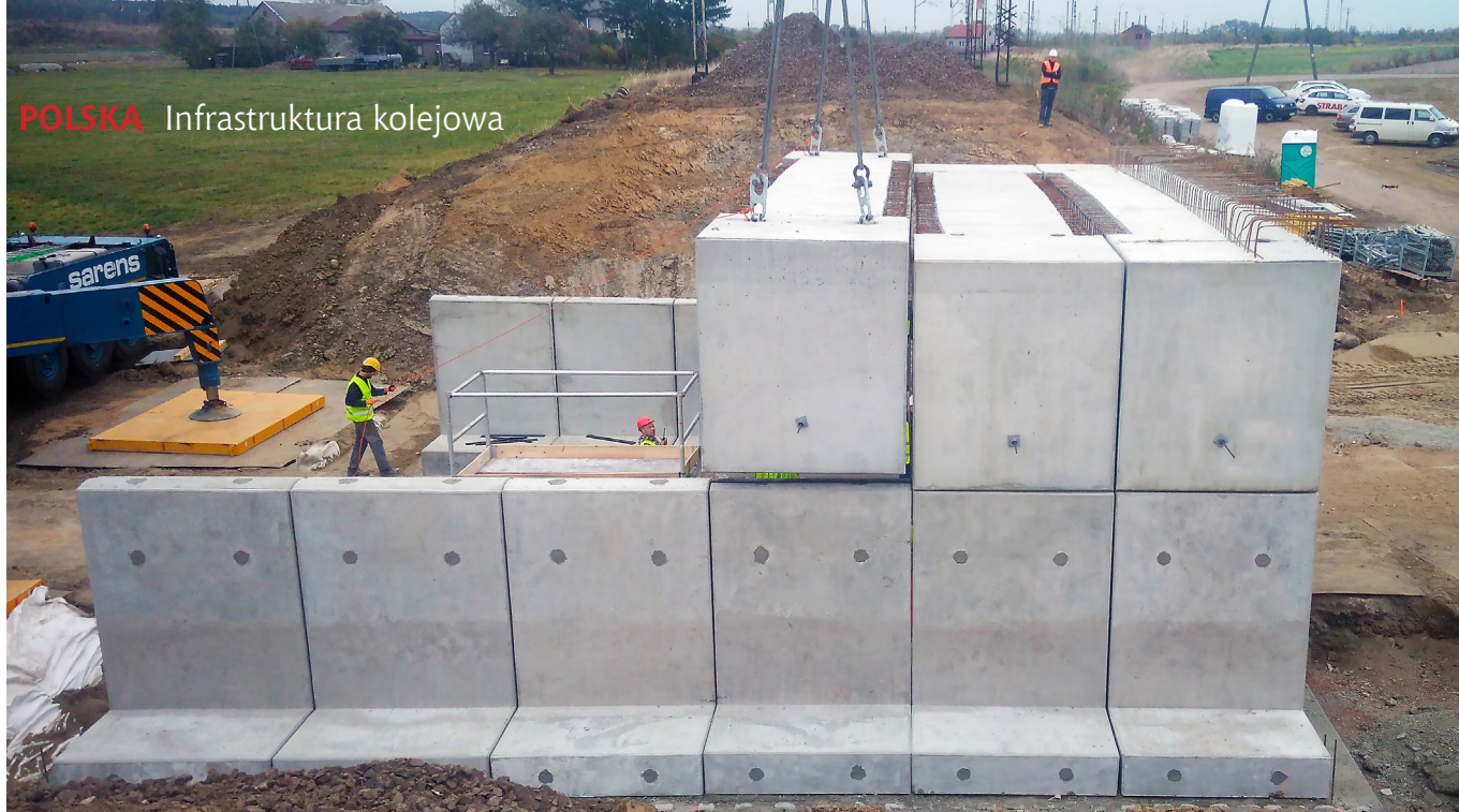
Ryc. 2. Montaż elementów ramowych na wcześniej ustawionych podporach
