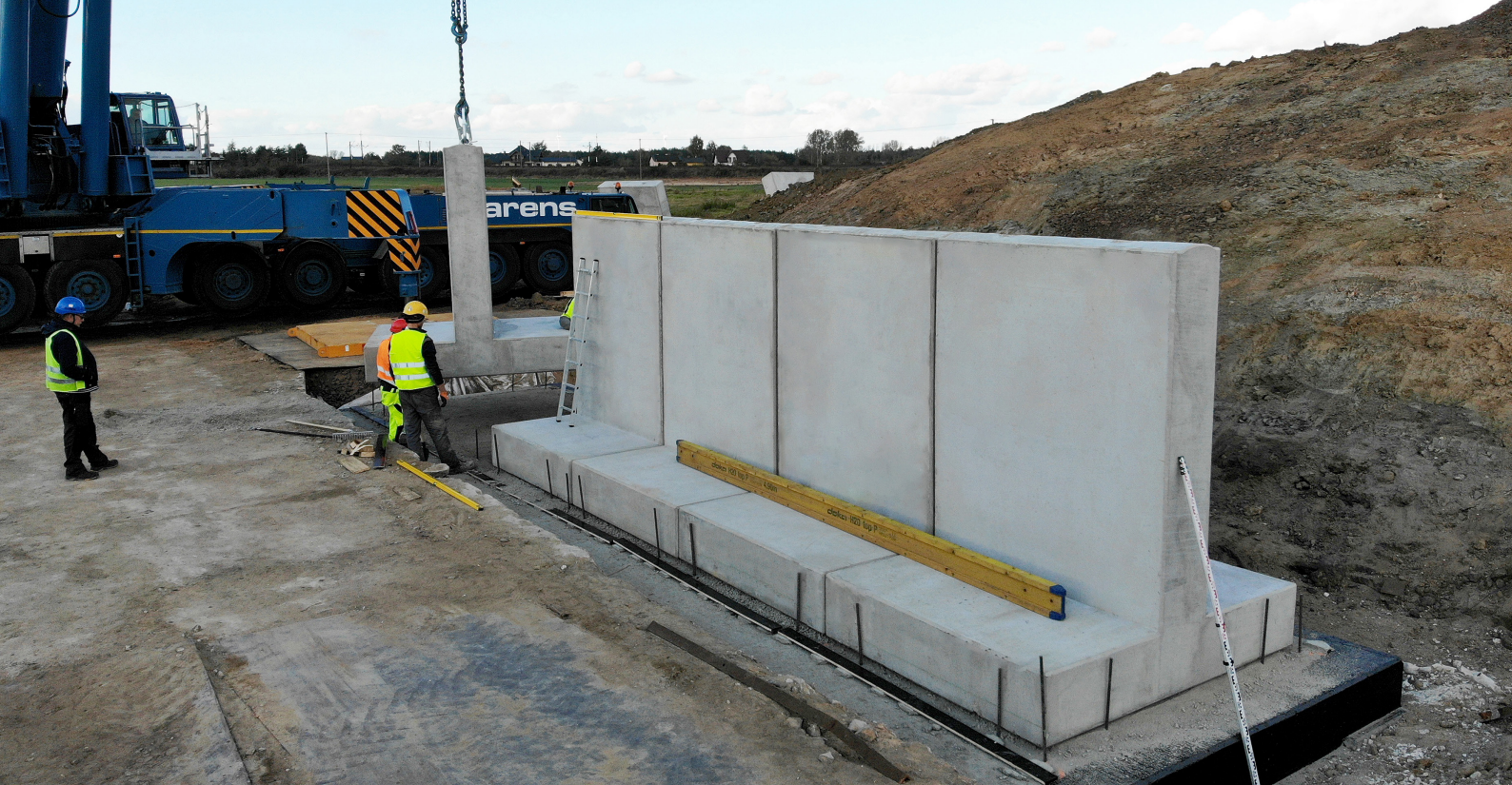
Ryc. 1. Montaż ścian podporowych
