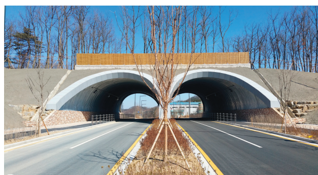
Fot. 3. Przejście dla zwierząt z blach falistych optemPLATE
