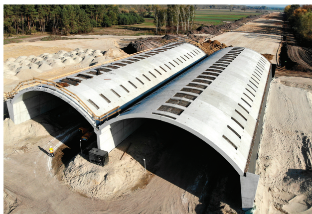
Fot. 2. Budowa przejścia dla zwierząt z zastosowaniem prefabrykatów optemARCH na drodze S5 Poznań – Wrocław
