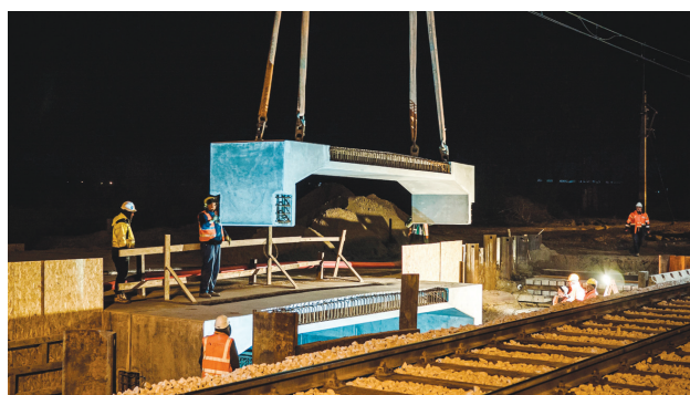
Fot. 1. Obiekt kolejowy na odcinku Ozorków-Łęczycza
