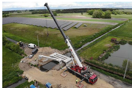
Fot. 2. Stawiszyn – ustawianie prefabrykatów optemFRAME
