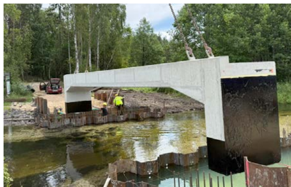
Fot. 5. Szwedzki Ostrów – ustawienie pierwszego elementu
