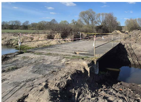
Fot. 1. Stawiszyn – obiekt przed remontem
