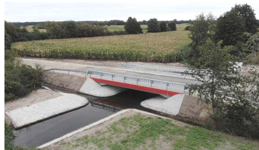
Fot. 3. Stawiszyn – ukończona inwestycja
