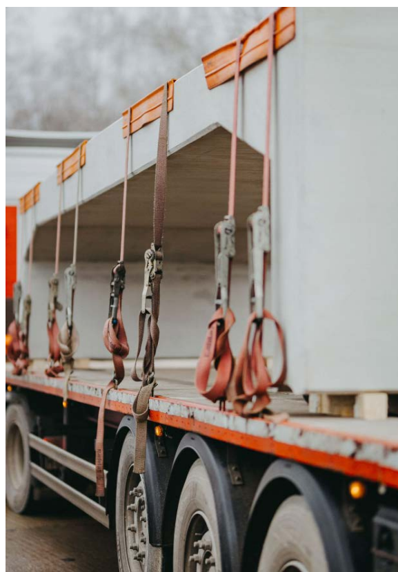
Fot. 7. Transport prefabrykatów ramowych optemFRAME
