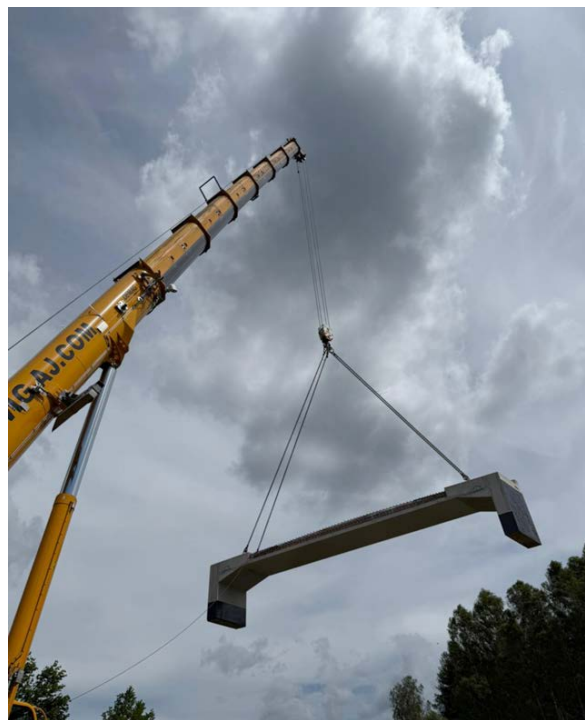
Fot. 4. Szwedzki Ostrów – montaż prefabrykatów ramowych optemFRAME
