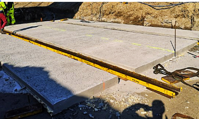
Ryc. 1. Belki ślizgowe w korytkach ławy fundamentowej, fot. ELPO
