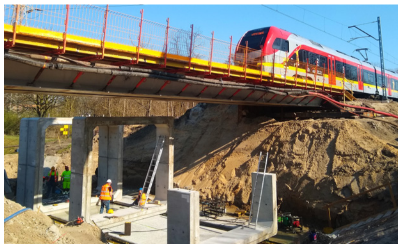
Ryc. 2. Montaż prefabrykatów metodą hydraulicznego wsuwania pod ruchem kolejowym
