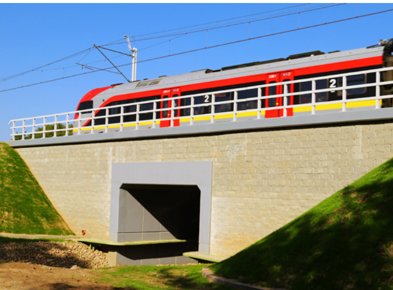
Ryc. 4. Gotowa konstrukcja mostu
