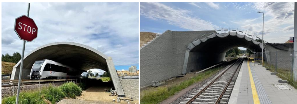
Rysunek 5. Ruch kolejowy w czasie budowy obiektu oraz widok od strony peronu. [2]
