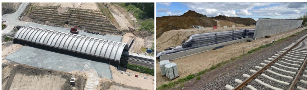
Rysunek 6. Widok na nasypy drogowo oraz etapowe wznoszenie ścian oporowych. [2][4]
