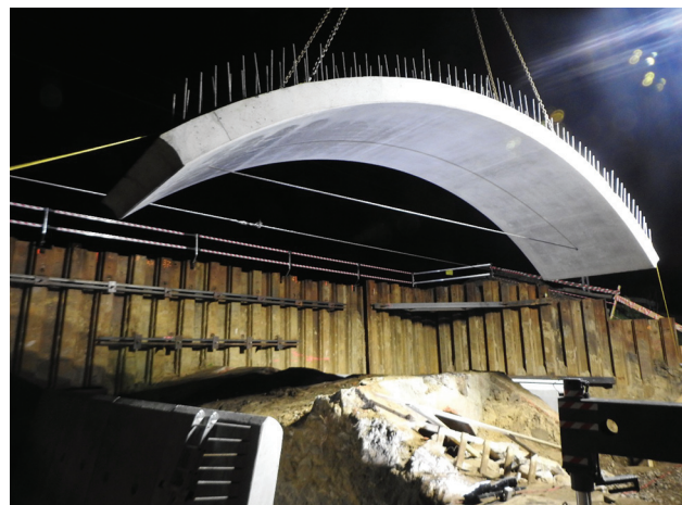
Fot. 2. Montaż łuków prefabrykowanych
