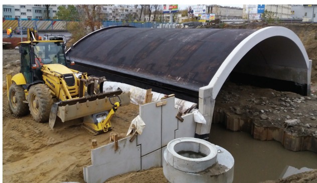
Fot. 4. Alternatywne rozwiązanie przyobiektowych murów oporowych
