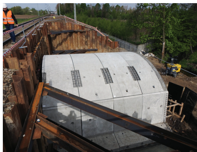
Fot. 3. Zmontowana „połówka” mostu w km 267,333 linii kolejowej E20
