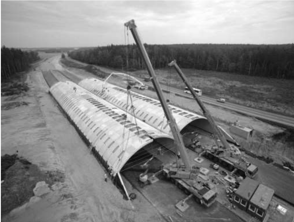
Rys. 15. Ostatni etap montażu prefabrykatów łukowych obiektu
