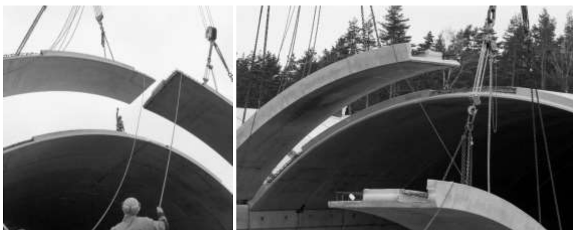
Rys. 14. Montaż prefabrykatów łukowych obiektu
