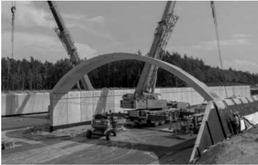
Rys. 10. Zmontowany łuk na jednym przęśle obiektu PE – 1.1
