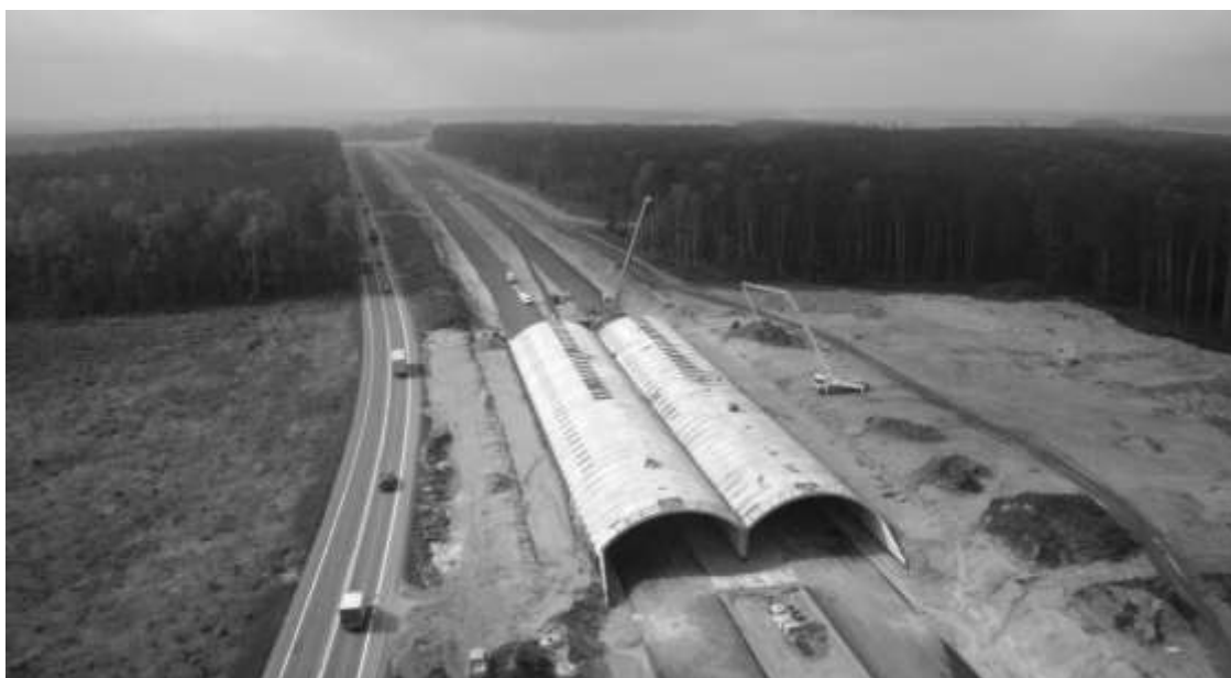
Rys. 1. Widok budowanego przejścia dla zwierząt PE-1.1
