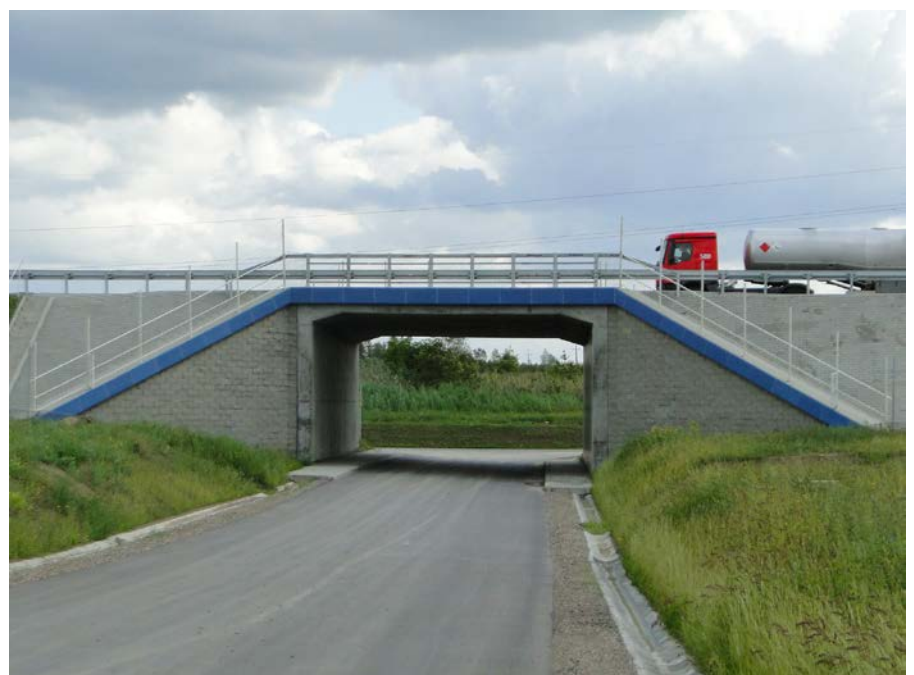
Rys. 9. Przykład zrealizowanego muru oporowego z gruntu zbrojonego
