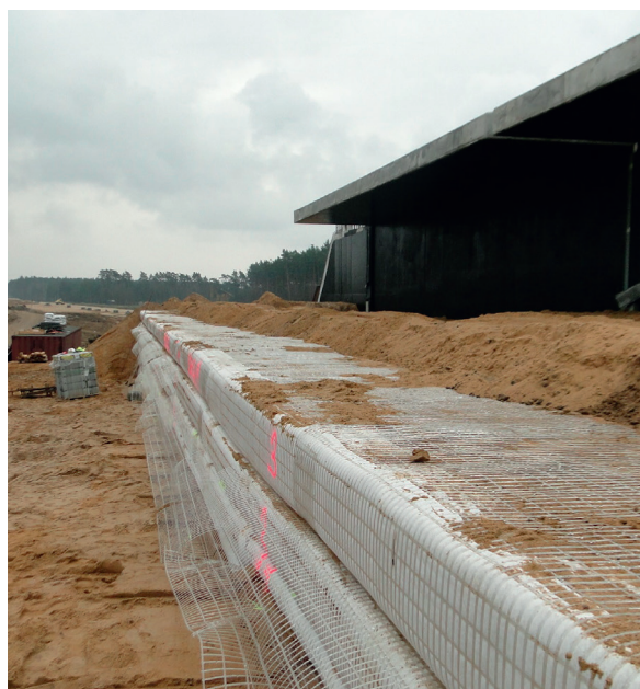
Rys. 4. Przykładowa realizacja w systemie biernym optemBLOK
