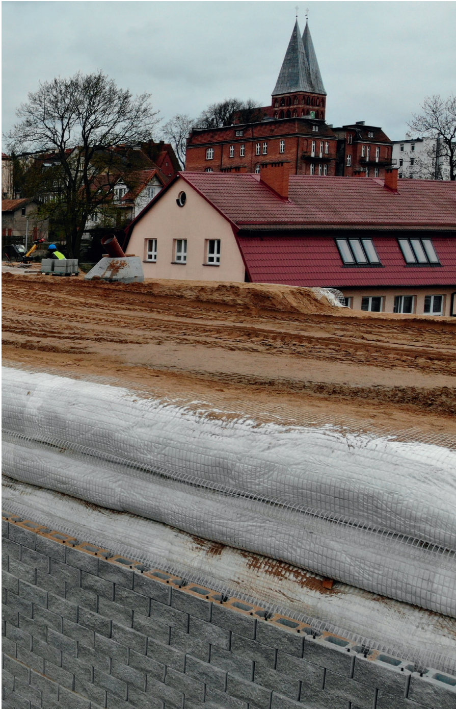
Rys. 5. Etap wznoszenia lica w systemie biernym optemBLOK
