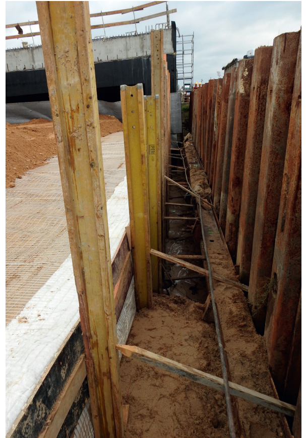
Rys. 6. Przykładowa realizacja tymczasowej ściany oporowej w technologii optemBLOK
