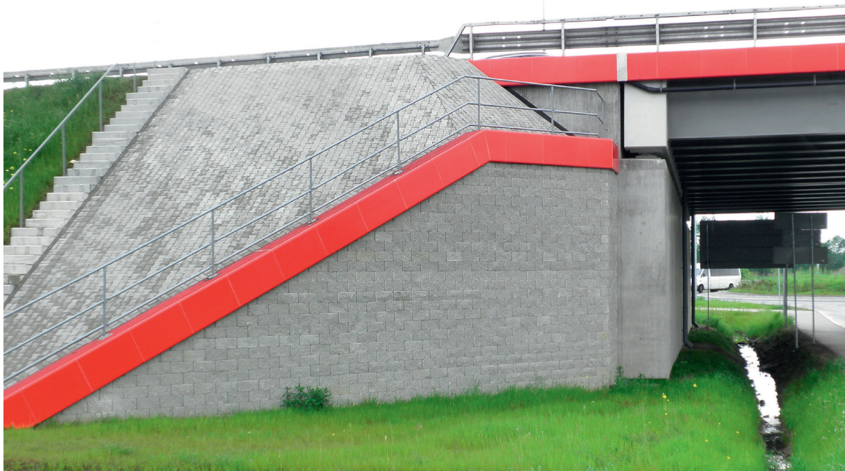
Rys. 2. Przykładowa realizacja w systemie czynnym optemBLOK
