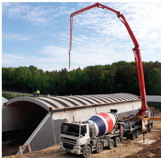
Fot. 2. Betonowanie i uciąganie zamków
