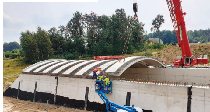
Fot. 1. Montaż prefabrykatów
