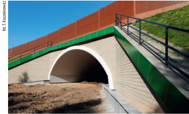
Fot. 1. Przejście dla zwierząt PZ-2
