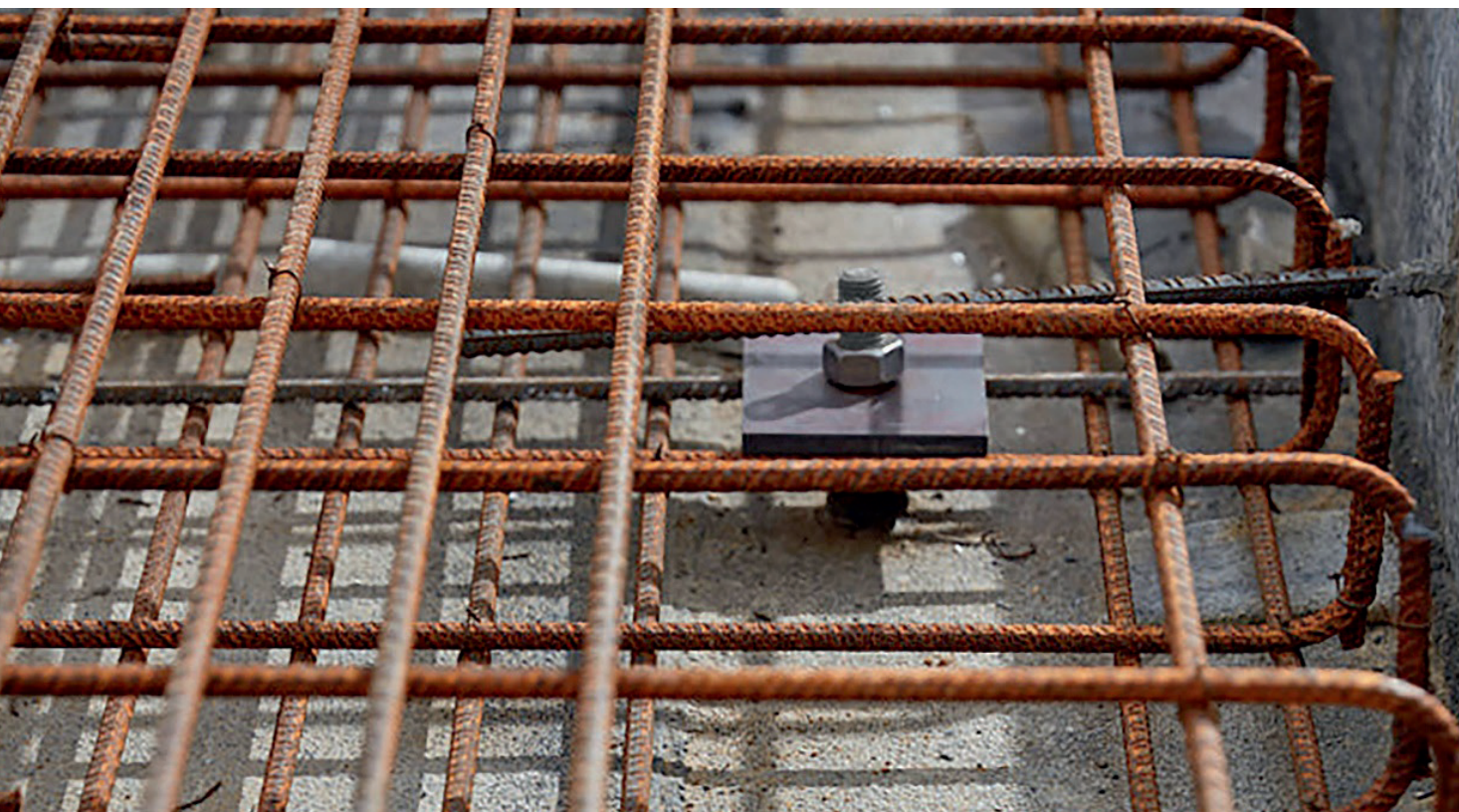
Ryc. 3. Wklejana kotwa kapy chodnikowej
