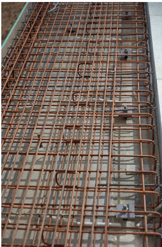
Ryc. 2. Zamontowane kotwy przed betonowaniem kapy
