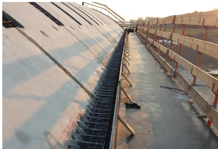
Ryc. 7. Zabetonowane zamki w kluczu prefabrykatów
