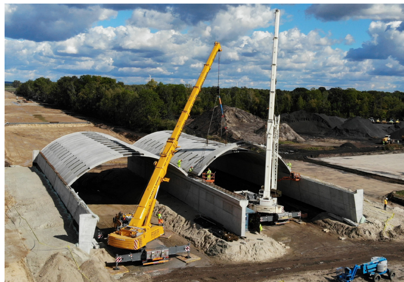
Ryc. 5. Montaż metodą leaf by leaf
