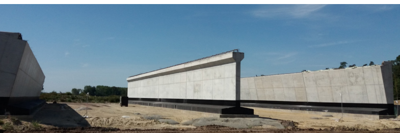
Ryc. 2. Zakończony podpory obiektu, przygotowane do montażu prefabrykatów
