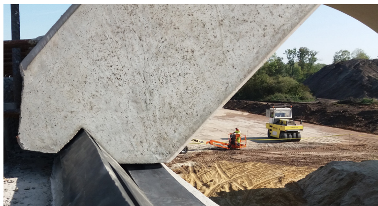
Ryc. 3. Oparcie prefabrykatów na ścianie przyczółka
