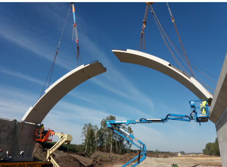
Ryc. 4. Montaż metodą leaf by leaf
