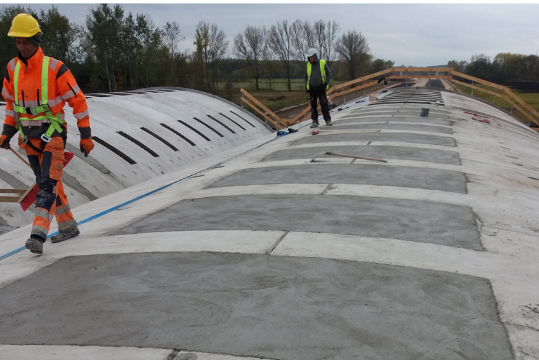
Ryc. 6. Węzeł uciągający na podporze skrajnej przygotowany do betonowania
