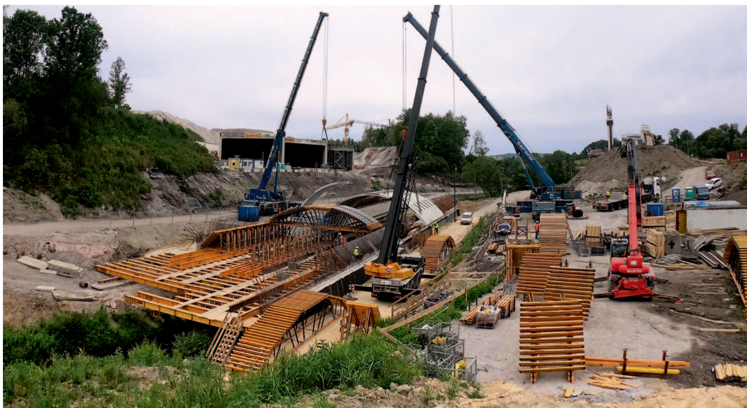
Fot. 4. Montaż konstrukcji prefabrykowanej o kształcie łukowym. Na pierwszym planie widoczne deskowanie części monolitycznej
