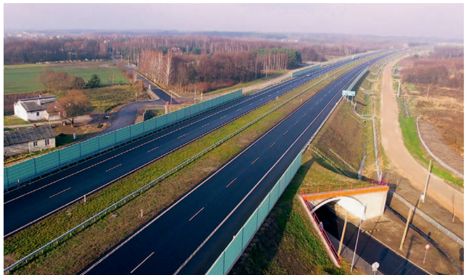
Fot. 8. Przykład realizacji konstrukcji prefabrykowanej. Droga 57 – obwodnica Radomia. Kontynuacja przekroju drogowego nad obiektem. Źródło: GDDKiA
