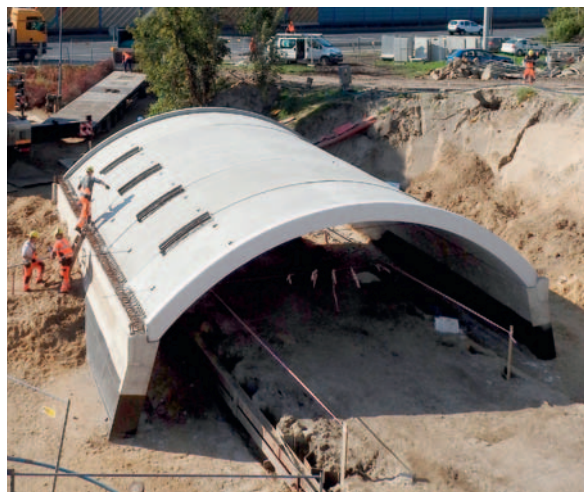
Fot. 2. Zmontowane przejście pod torami – Linia Obwodowa Warszawy
