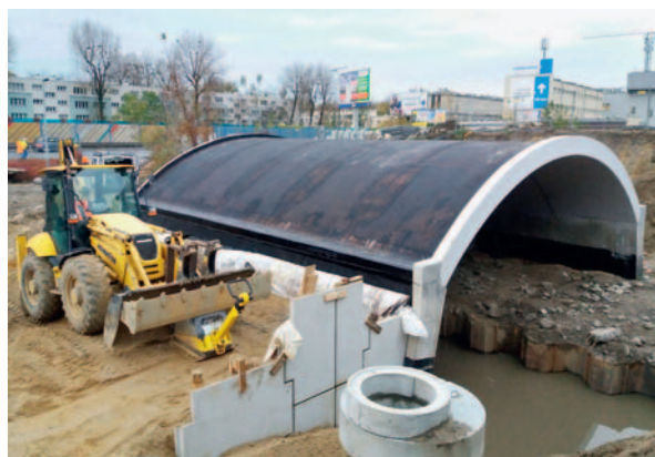
Fot. 3. Mury z gruntu zbrojonego z oblicowaniem z paneli żelbetonowych – Linia Obwodowa Warszawy
