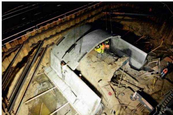
Fot. 5. Nocny montaż prefabrykowanych łuków – LCS Konin
