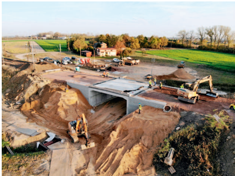
Fot. 9. Roboty przygotowawcze do ułożenia podtorza – LCS Kutno
