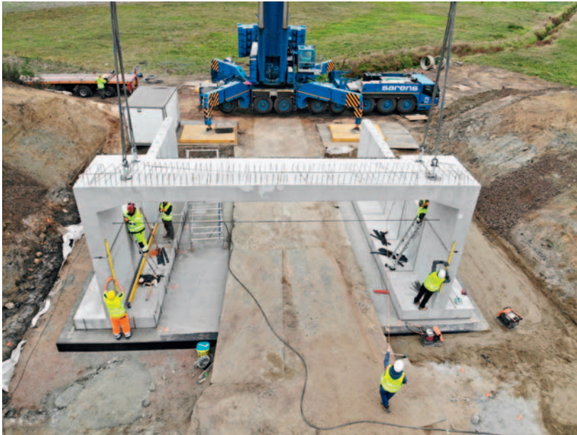
Fot. 7. Montaż prefabrykowanych segmentów górnych – LCS Kutno
