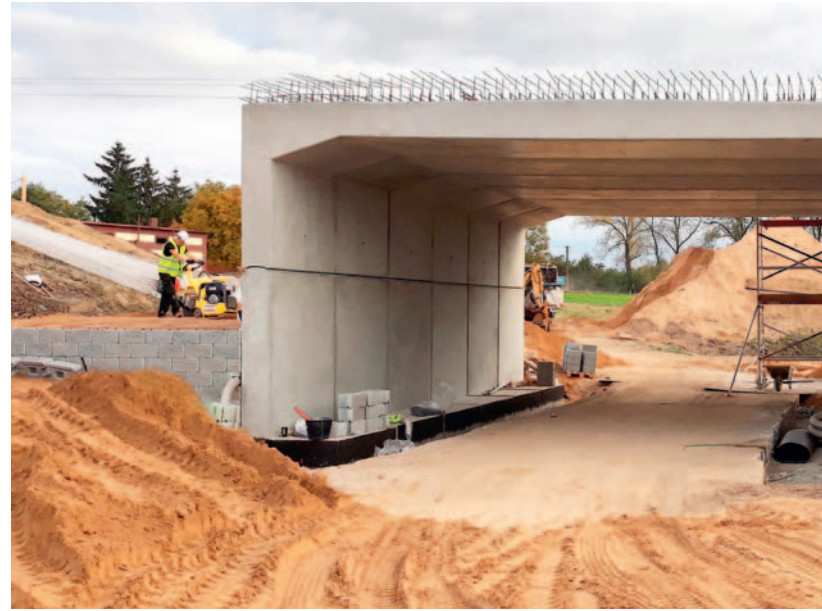
Fot. 8. Nakładanie izolacji przy jednoczesnym wznoszeniu murów oraz wykonywaniem zasypek – LCS Kutno
