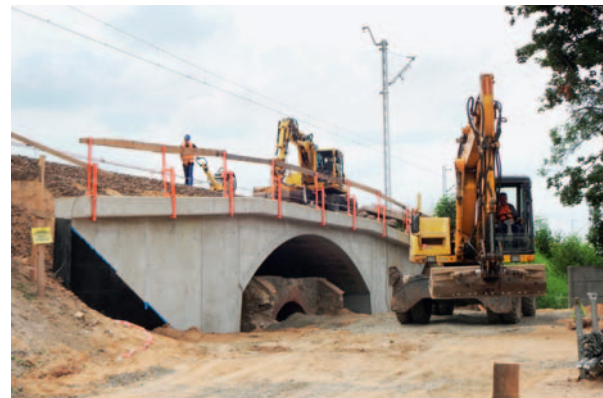
Fot. 6. Widok na monolityczny mur od czoła mostu – LCS Konin
