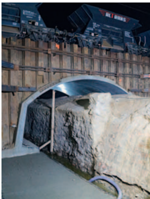
Fot. 4. Most przygotowany do drugiego etapu montażu – LCS Konin
