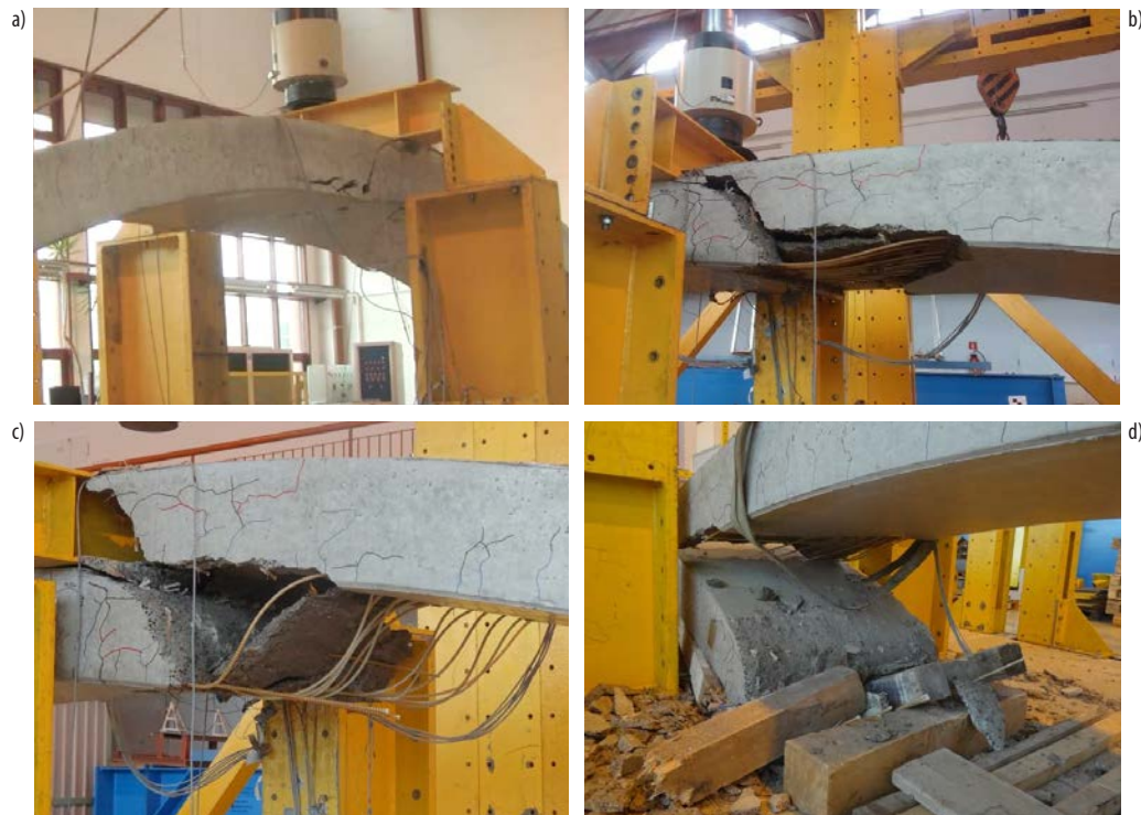
Rys. 6. Postać zniszczenia modelu LG1: a) inicjacja pęknięcia w środku rozpiętości, b-c) widok elementu po zniszczeniu (prawa połowka łuku zaklinowana o belkę trawersową), d) widok elementu po zniszczeniu i zdemontowaniu belki trawersowej
