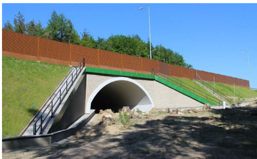
Rys. 1. Przykład wykorzystania prefabrykatów łukowych do budowy wiaduktu
