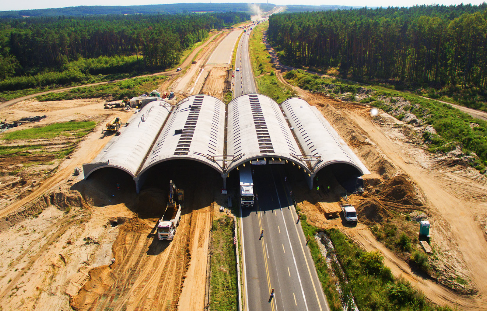
Górne przejście dla zwierząt PZGd-3 na autostradzie A1 na odcinku C, Kamieńsk – Radomsko
