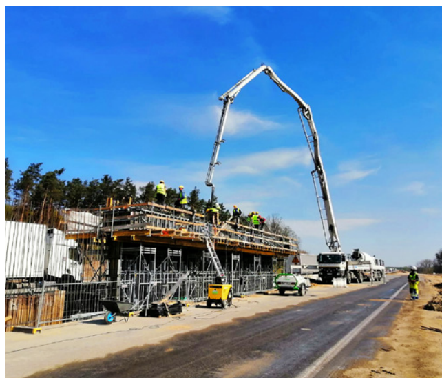
Ryc. 1. Betonowanie podpory żelbetowej
