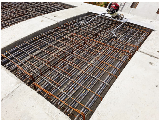
Ryc. 4. Zamek w kluczu przygotowany do zabetonowania
