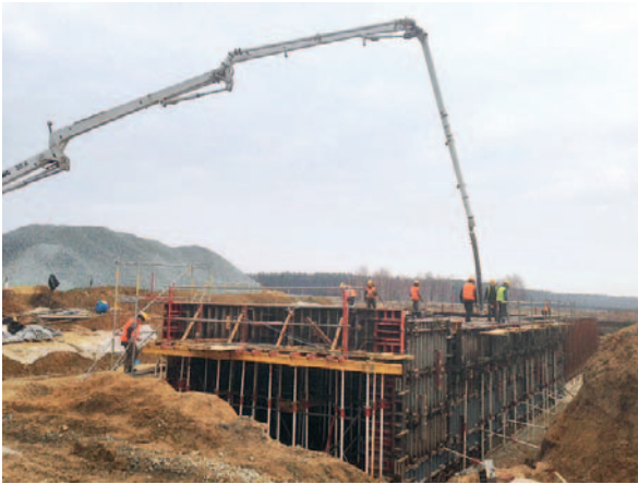
Fot. 4. Obiekt 41T – przepust o konstrukcji monolitycznej (fot. dzięki uprzejmości firmy Dragados)
