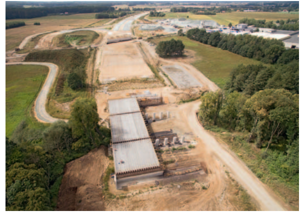
Fot. 11. Obiekt MS-23 – widok z góry po zakończonym montażu belek T na jednym z pomostów (fot. dzięki uprzejmości GDDKiA O. Wrocław)
