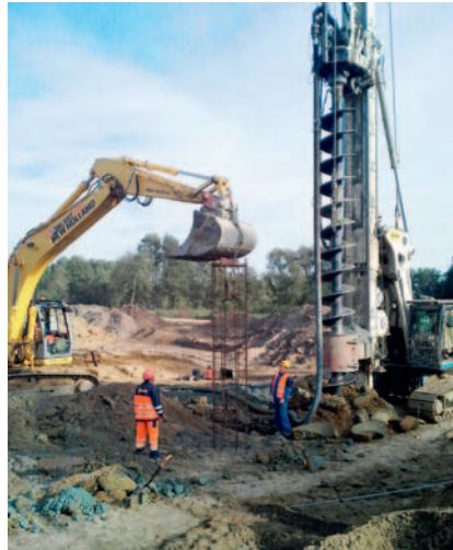
Fot. 7. Obiekt MS-25 – wykonywanie pali wierconych CFA (fot. dzięki uprzejmości firmy Dragados)
