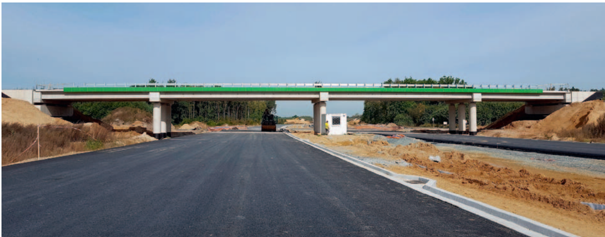
Fot. 13. Obiekt WD-17 – widok z boku (fot. dzięki uprzejmości GDDKiA O. Wrocław)
