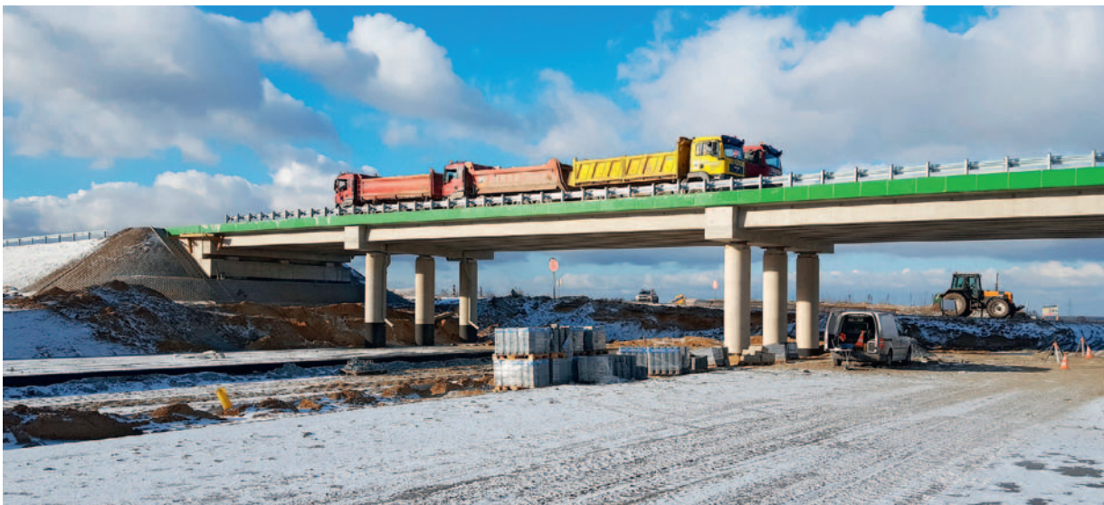
Fot. 14. Obiekt WD-20 – w trakcie próbnych obciążeń obiektu (fot. dzięki uprzejmości GDDKiA O. Wrocław)
