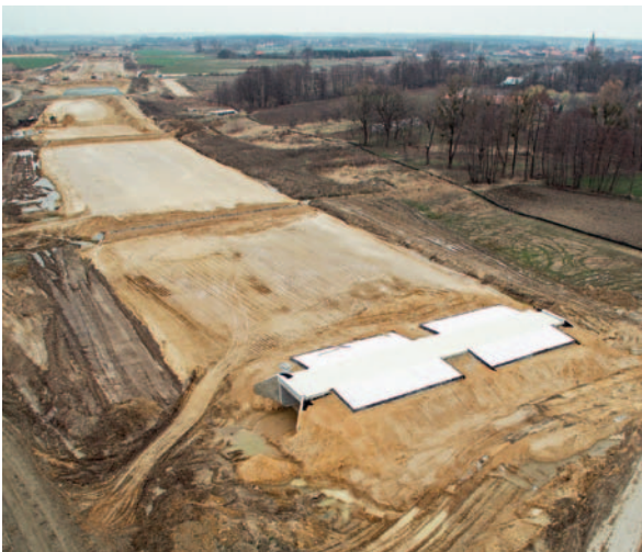
Fot. 5. Obiekt 35T – przejście pieszo-rowerowe (fot. dzięki uprzejmości GDDKiA O. Wrocław)
