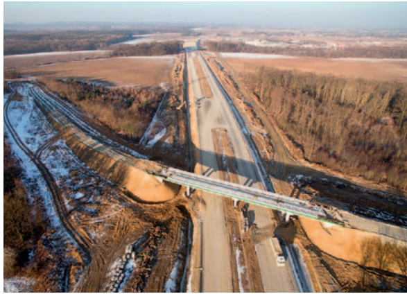
Fot. 10. Obiekt WD-24 – widok z góry (fot. dzięki uprzejmości GDDKiA O. Wrocław)
