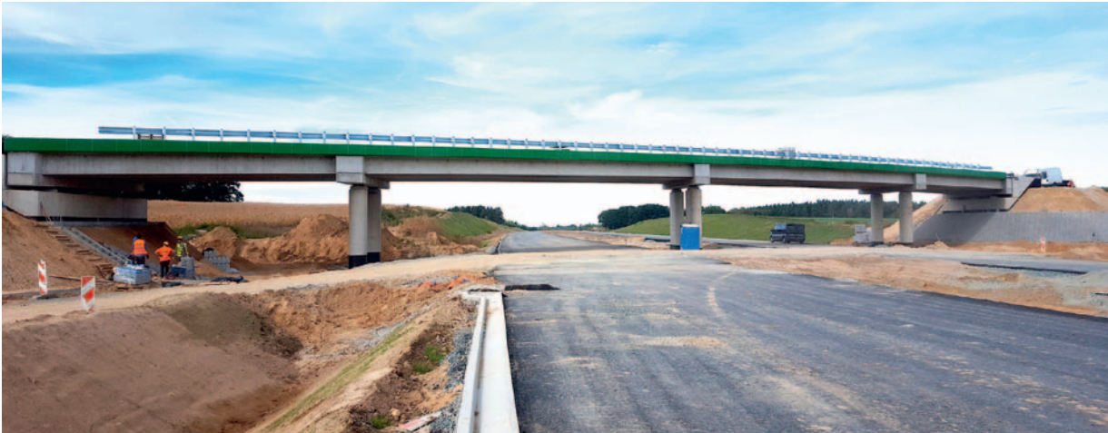
Fot. 12. Obiekt WD-26 – widok z boku (fot. dzięki uprzejmości GDDKiA O. Wrocław)
