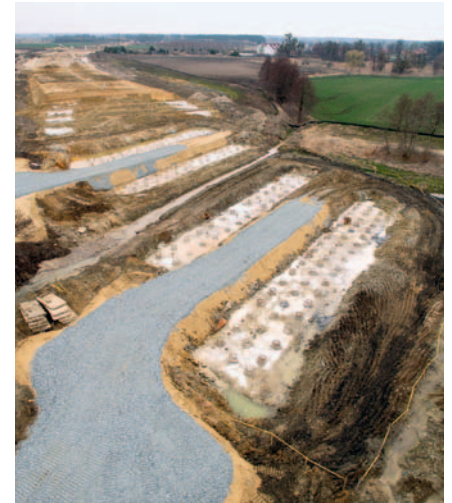
Fot. 8. Obiekt MS-25 – wykonane pale wiercone CFA (fot. dzięki uprzejmości GDDKiA O. Wrocław)
