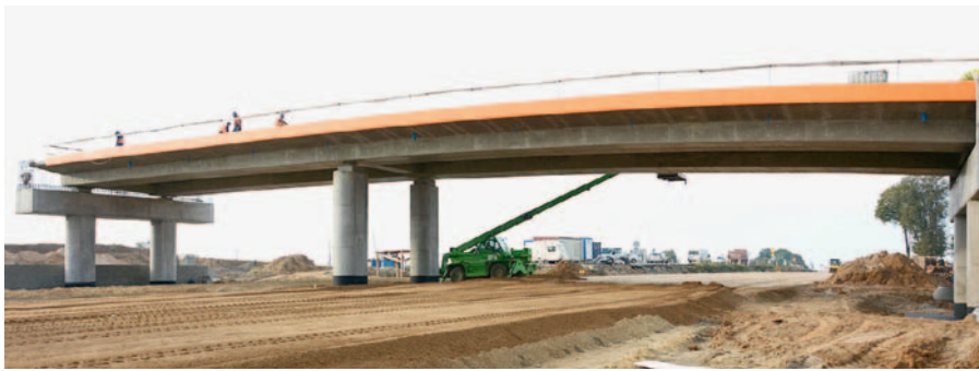
Fot. 11. Obiekt WD-13 – konstrukcja sprężona w trakcie budowy (fot. A. Makowska)
