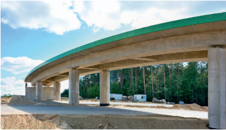
Fot. 3. Objekt WD-16 – konstrukcja dwudźwigarowa żelbetowa (fot. A. Makowska)
