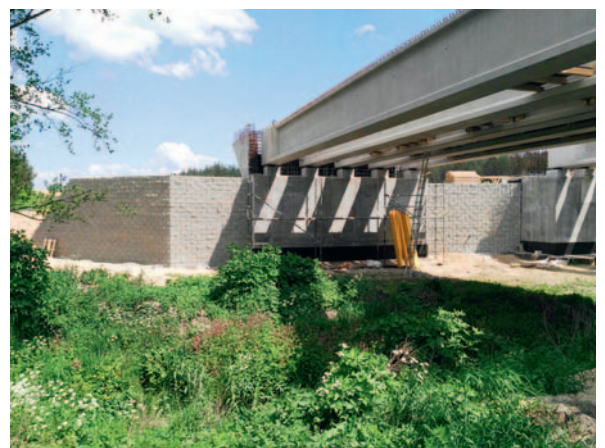
Fot. 14. Obiekty 9 i 9A – konstrukcja z belek prefabrykowanych, strunobetonowych typu I oraz mury oporowe z gruntu zbrojonego optemBLOK (źródło: materiały firmy Optem s.c.)
