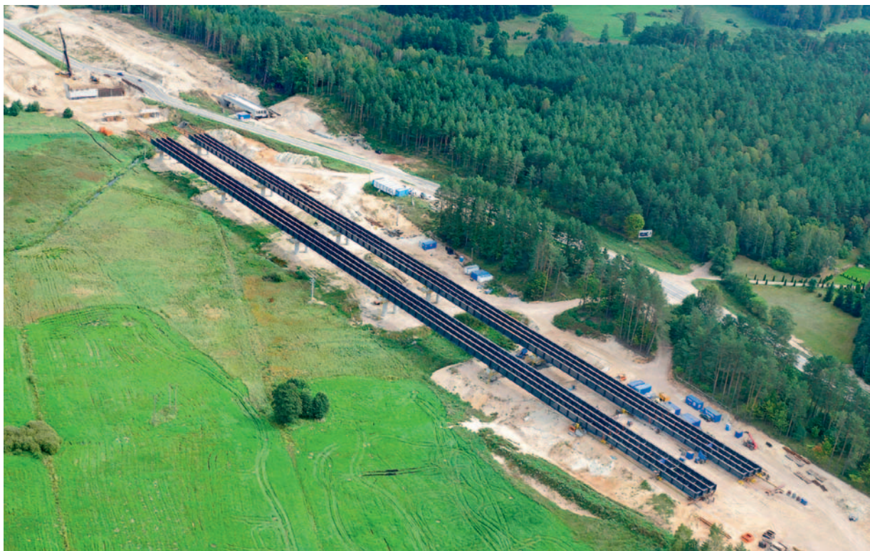
Fot. 1. Obiekt 8 – nasuwanie konstrukcji stalowej (fot. M. Czerepowicki)
