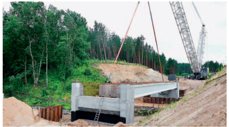
Fot. 8. Obiekt 8A – układanie belek strunobetonowych (fot. A. Makowska)
