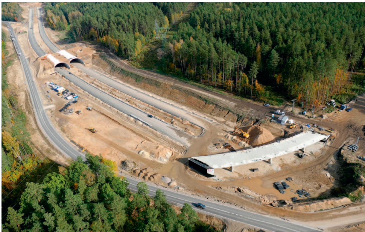
Fot. 2. Obiekty WD-3 i 3 (fot. M. Czerepowicki)
