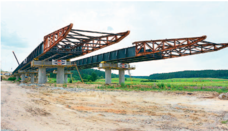
Fot. 5. Objekt 8 – nasuwanie konstrukcji stalowej (fot. A. Makowska)
