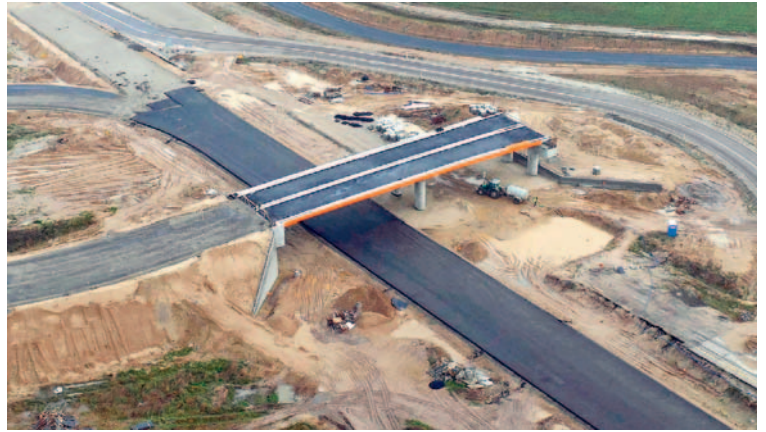
Fot. 4. Objekt WD-13 – konstrukcja sprężona (fot. M. Czerepowicki)
