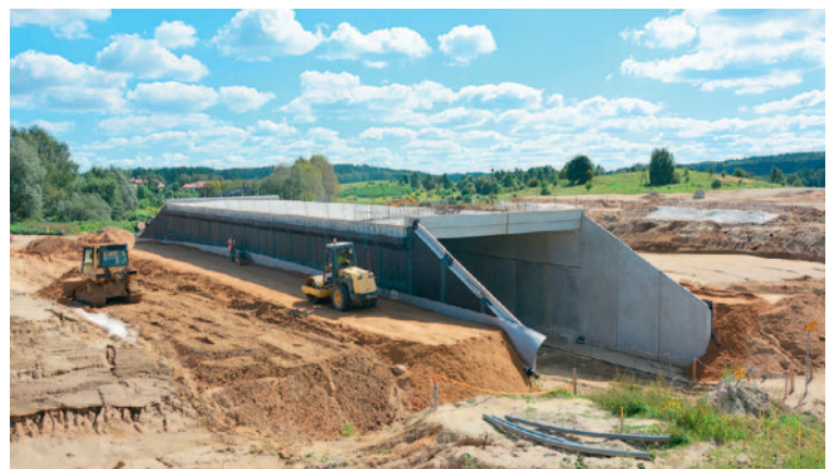
Fot. 10. Obiekt PG-1 – konstrukcja ramowa prefabrykowana (fot. A. Makowska)
