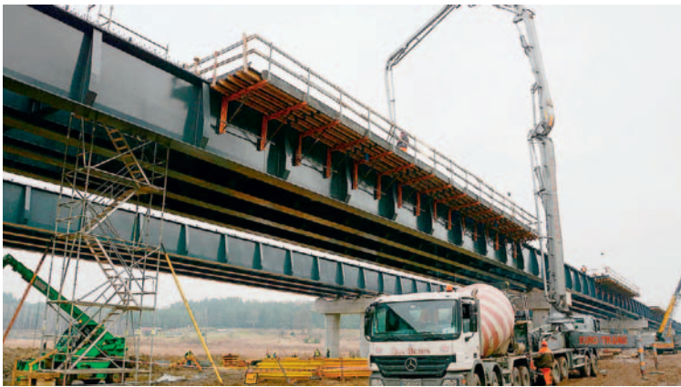
Fot. 7. Obiekt 8 – betonowanie płyty pomostu (fot. A. Makowska)
