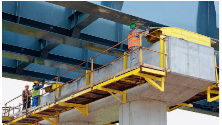
Fot. 6. Objekt 8 – łożyska ślizgowe w trakcie nasuwania (fot. A. Makowska)
