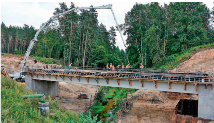
Fot. 9. Obiekt 8A – betonowanie płyty pomostu (fot. A. Makowska)
