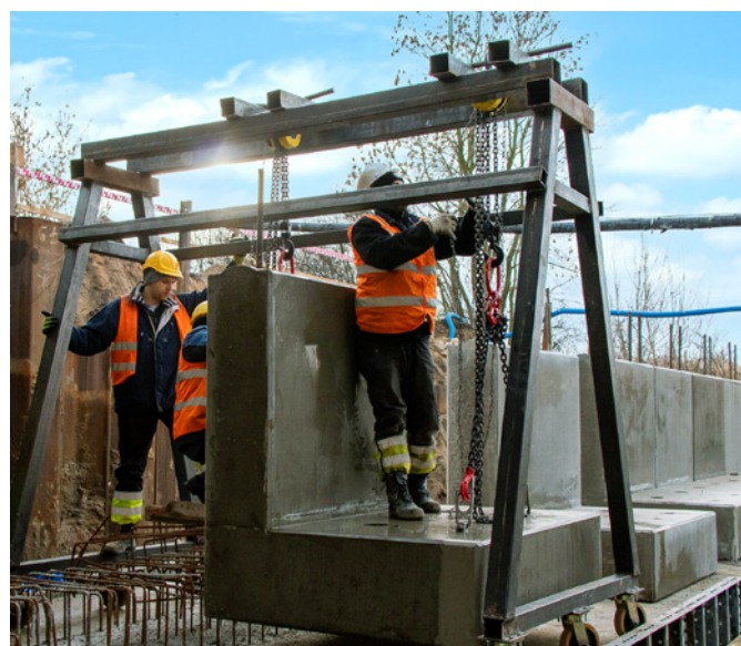
Transport prefabrykowanych podpór pod konstrukcję tymczasową
