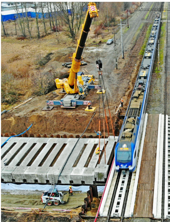
Montaż prefabrykatów ramowych optemFRAME
