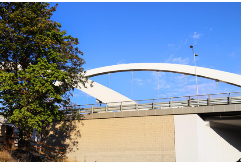
Ściana oporowa w systemie bloczków drobnowymiarowych zbrojona geosyntetykami
