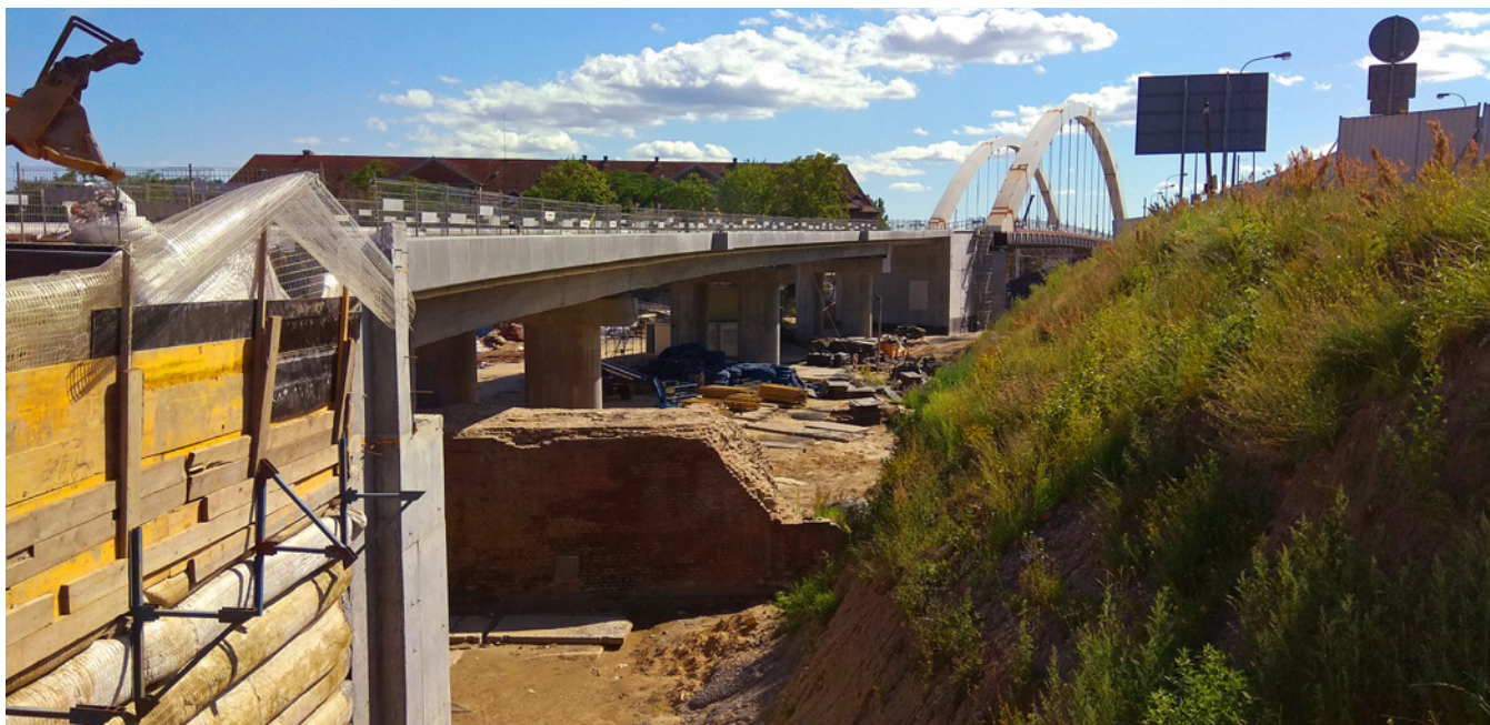
Pierwszy etap prac – zamontowano dwa dźwigary stalowe oraz wykonano ścianę tymczasową ze zbrojeniem z geosyntetyków
