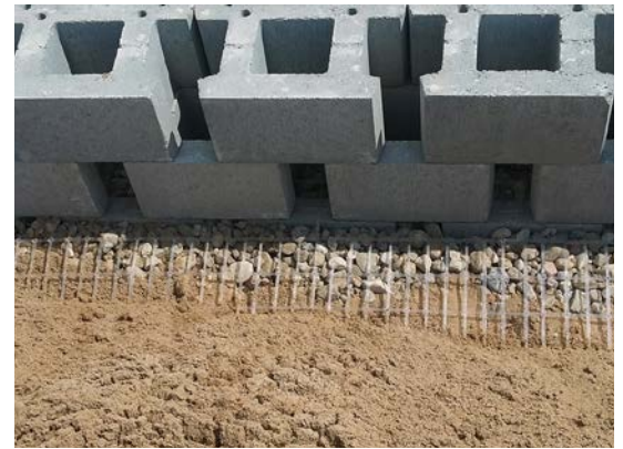
Fot. 4. Mur oporowy w trakcie realizacji – widok od strony zasypki muru
