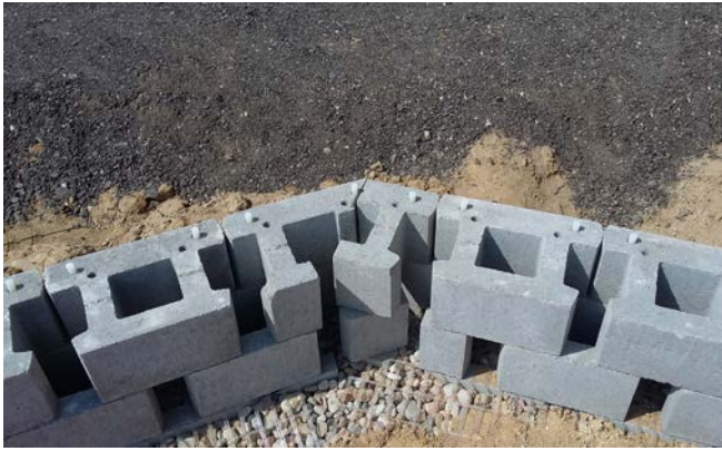
Fot. 2. Szczegół narożnika rozwartego
