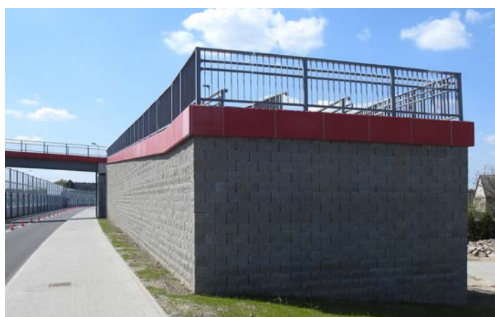
Fot. 8. Zastosowanie murów oporowych z elementów drobnowymiarowych znajduje zastosowanie również w przypadku kładek
