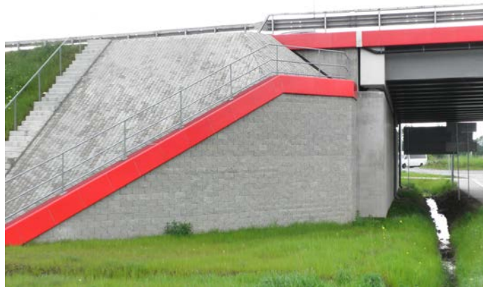
Fot. 6. Mury oporowe jako skrzydełka ukośne przy obiekcie mostowym WA1
