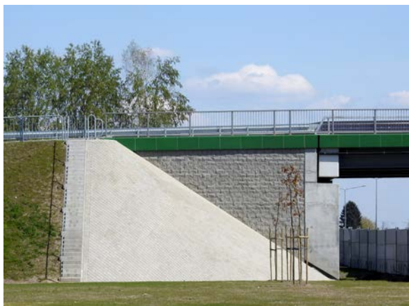
Fot. 5. Mur oporowy optemBLOK jako skrzydełko usytuowane wzdłuż drogi
