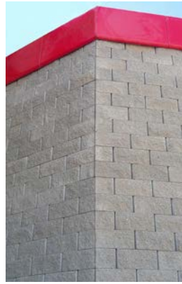
Fot. 3. System optemBLOK pozwala na kształtowanie estetycznych naroży
