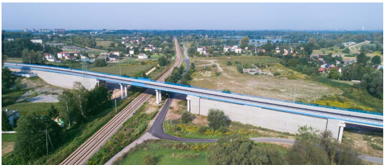
Fot. 3. Mur oporowy ograniczający nasyp dojazdowy
