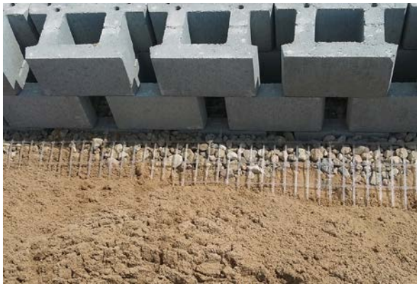
Fot. 1. Mur oporowy w trakcie realizacji – widok od strony zasypki muru
