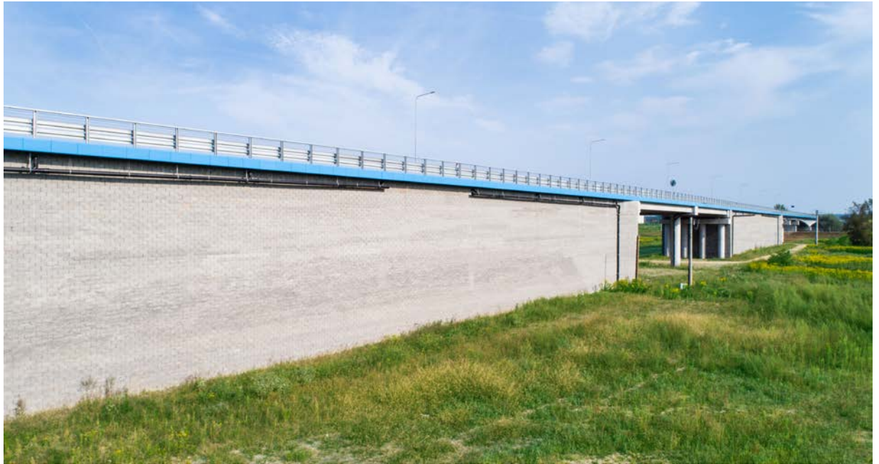
Fot. 2. Mury oporowe o konstrukcji skrzynkowej
