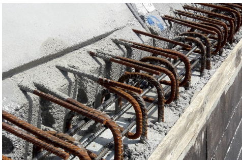
Rysunek 7. i 8. WS-19A - węzeł uciągający przed zabetonowaniem oraz obiekt w trakcie realizacji (widoczna górna płyta zespalająca)
