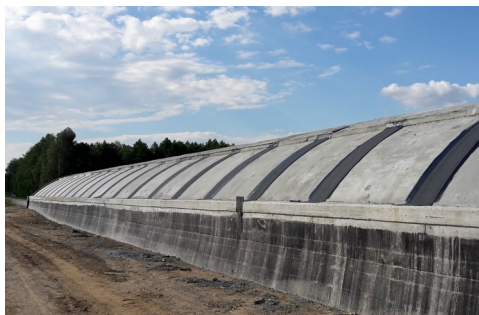
Rysunek 7. i 8. WS-19A - węzeł uciągający przed zabetonowaniem oraz obiekt w trakcie realizacji (widoczna górna płyta zespalająca)
