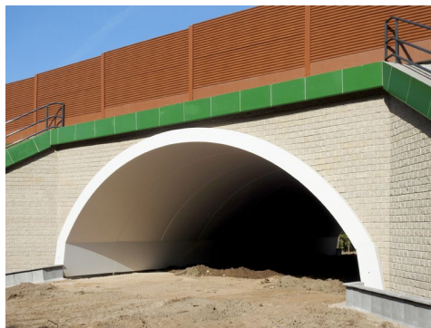
Rysunek 5. Obiekt PZ-2 przed oddaniem do użytku
