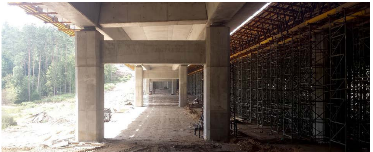
Fot. 5. Konstrukcja podpory pośredniej w trakcie budowy oraz rusztowanie pod ustrój nośny jezdni lewej
