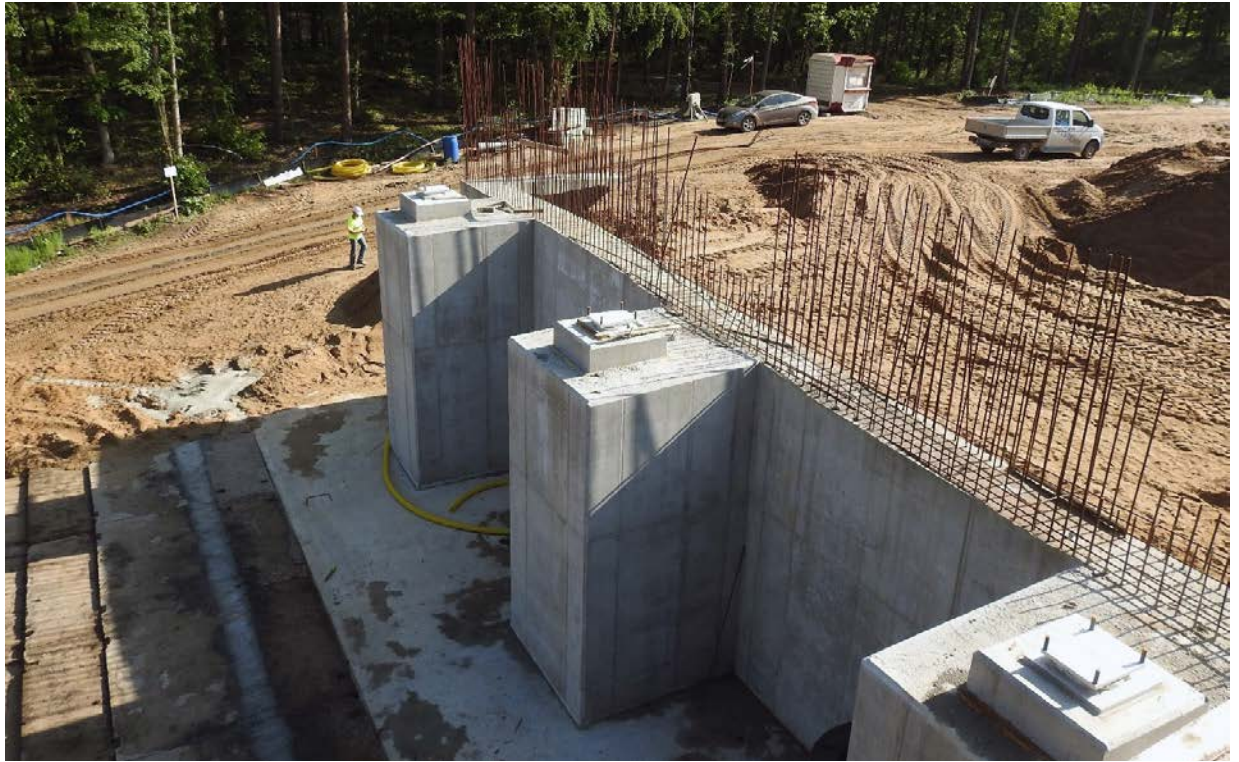
Fot. 4. Konstrukcja przyczółka w trakcie budowy
