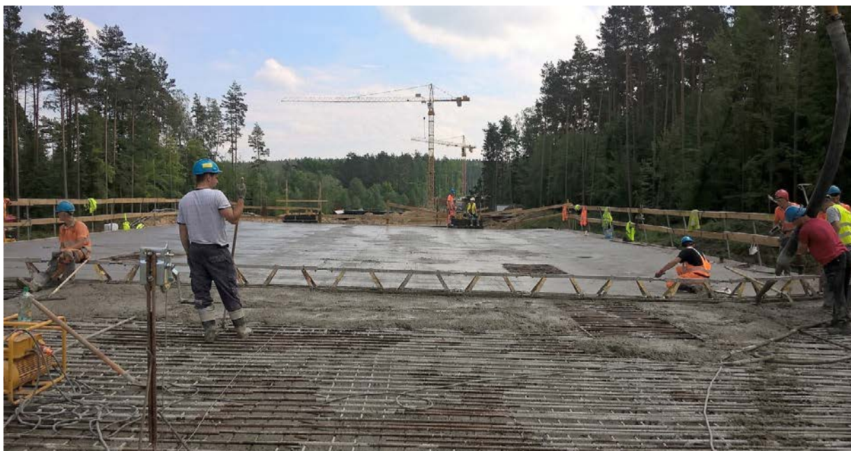
Fot. 3. Betonowanie ustroju nośnego jezdni prawej (fot. R. Blicharski)
