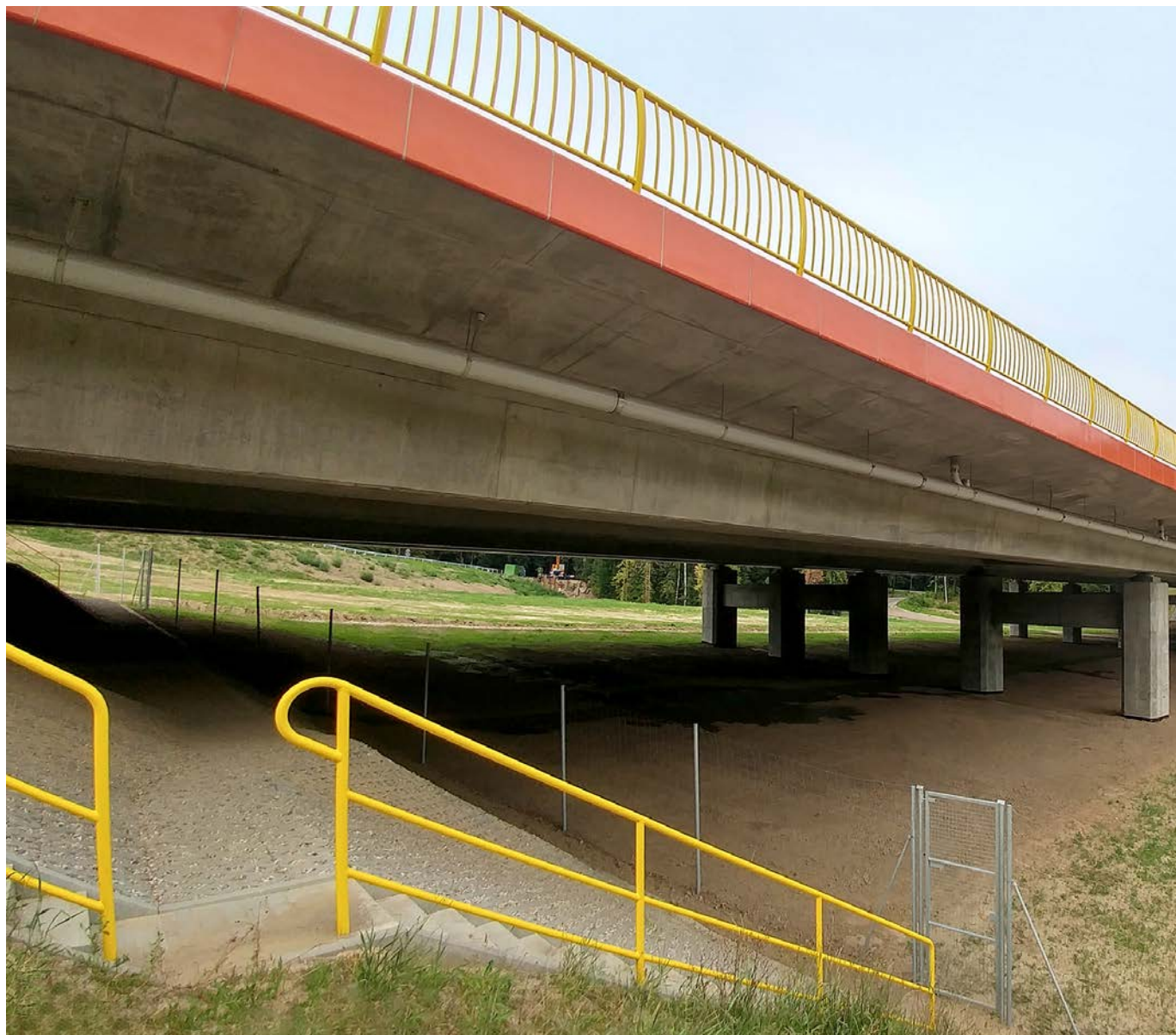
Fot. 1. Zrealizowany obiekt MS-30 (fot. B. Sybidło)
