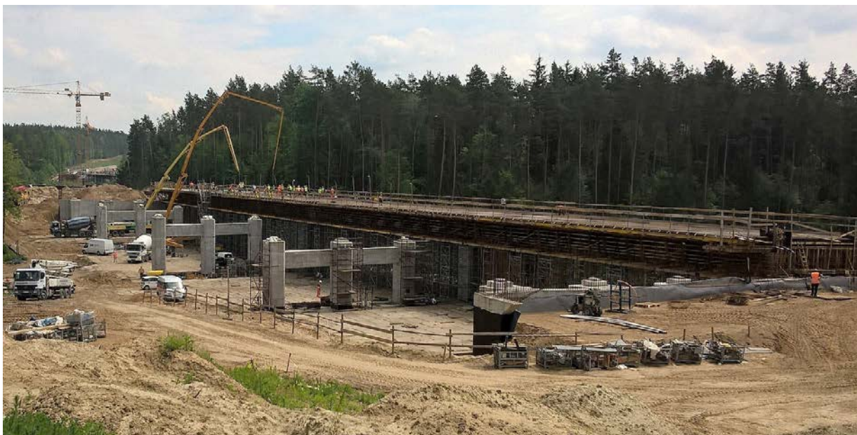
Fot. 2. Betonowanie ustroju nośnego jezdni prawej (fot. R. Blicharski)
