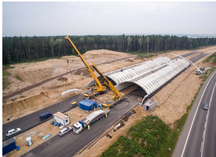
Fot. 5. Przygotowywanie do montażu kolejnego segmentu przejścia PE-1.1
