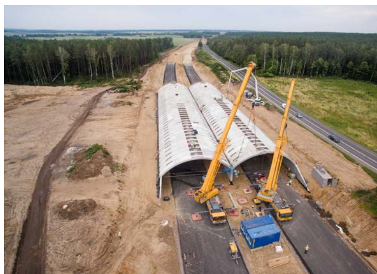
Fot. 7. Montaż sklepień łukowych przy jednoczesnym betonowaniu zamków
