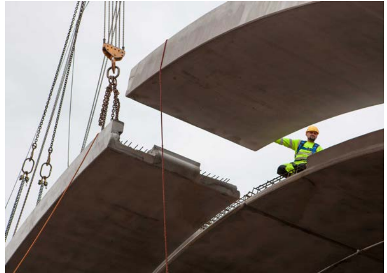
Fot. 3. Montaż leaf by leaf przejścia PE-1.1
