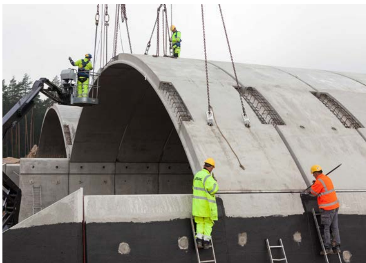
Fot. 4. Montaż górnych elementów przejścia PE-1.1
