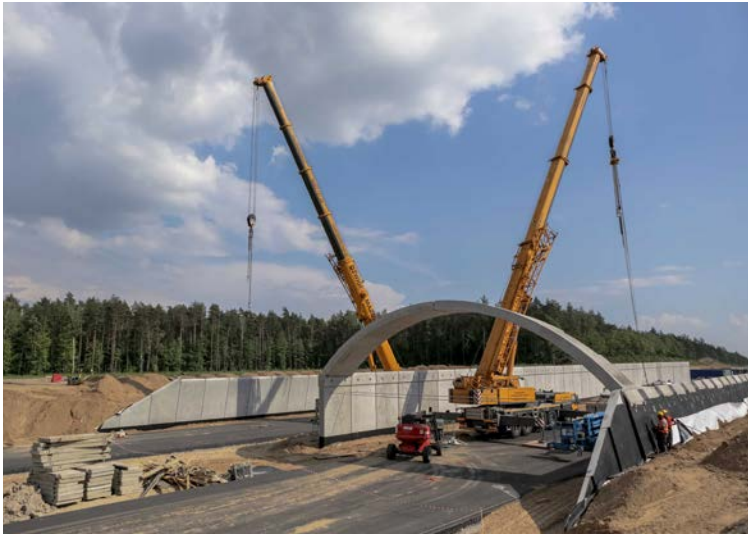
Fot. 2. Montaż leaf by leaf przejścia PE-1.1
