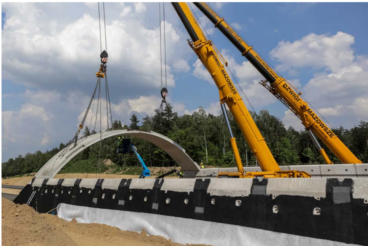
Fot. 1. Montaż łuków przejścia PE-1.1
