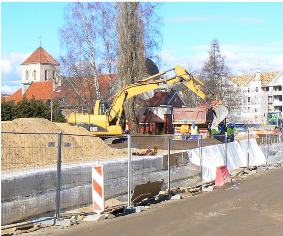
Fot. 2. Układanie warstwy keramzytu (fot. Geo-ekspert)
