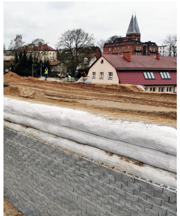
Fot. 3. Etap wznoszenia lica w systemie biernym optemBLOK
