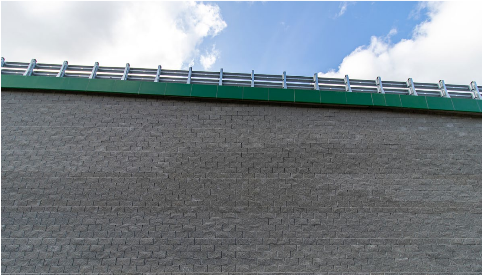
Fot. 4. Gotowa konstrukcja z gruntu zbrojonego
