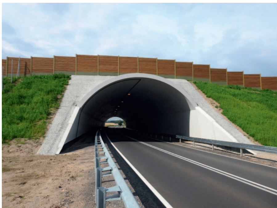
Rys. 1. Przykład wykorzystania prefabrykatów łukowych do budowy wiaduktu
