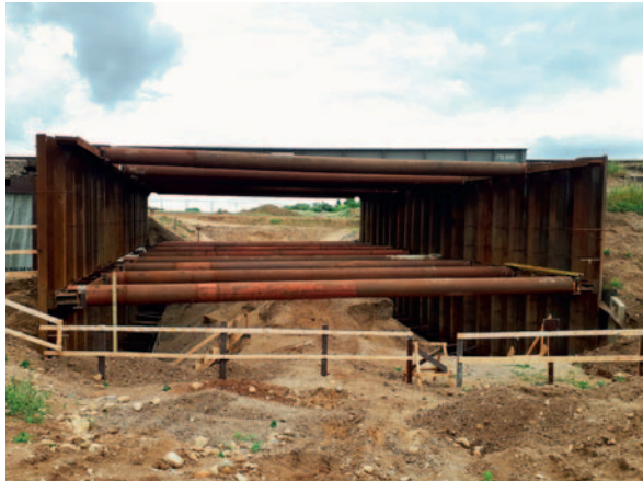
Fot. 1. Obiekt na etapie fazy V przed wbudowaniem betonu
