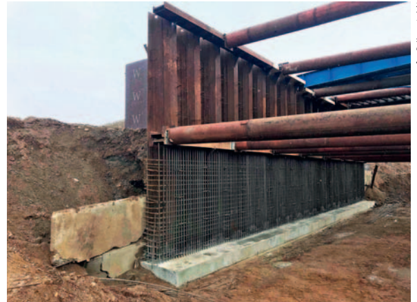
Fot. 2. Obiekt na etapie fazy V – betonowanie ścian podporowych
