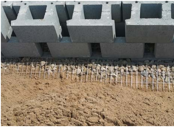
Fot.1. Mur oporowy w trakcie realizacji - widok od strony zasyпки muru (fot. Archiwum OPTEM sp. z o.o.)
