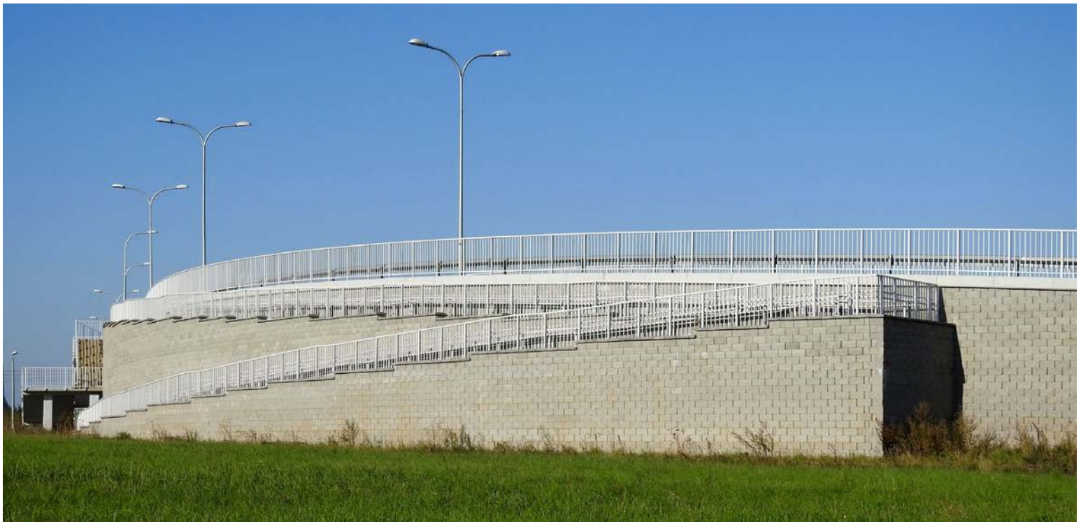
Fot. 4. Zastosowanie murów oporowych z elementów drobnowymiarowych znajduje zastosowanie również w przypadku pochylni (fot. Archiwum OPTEM sp. z o.o.)
