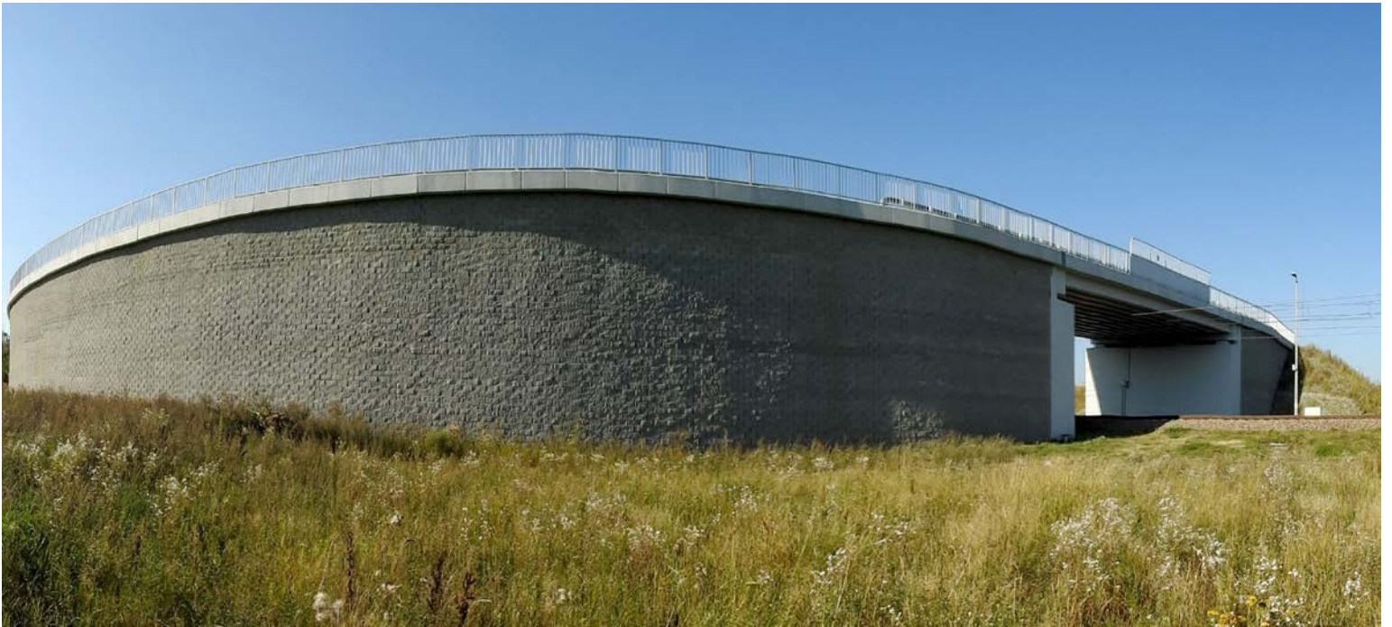
Fot. 3. Długie dojazdy do wiaduktów poprowadzone zostały po łuku (fot. Archiwum OPTEM sp. z o.o.)
