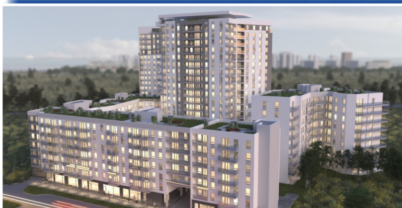
Budynek Mieszkalno-Uslugowy Gdańsk, ul. Starowiejska
