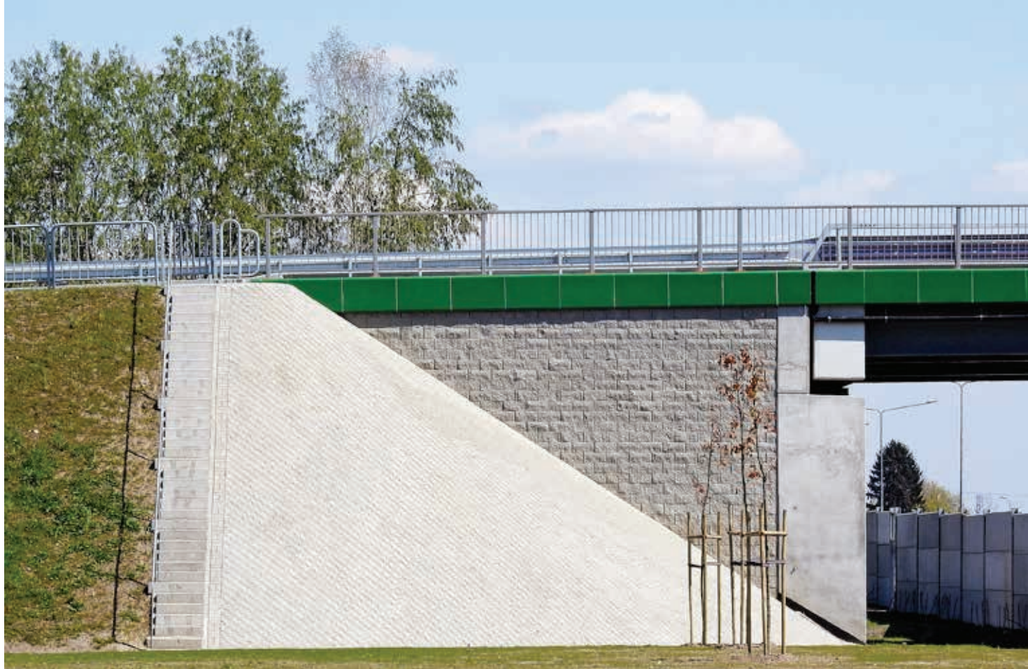
Ryc. 1. Ściana z gruntu zbrojonego jako przykład geosystemu
